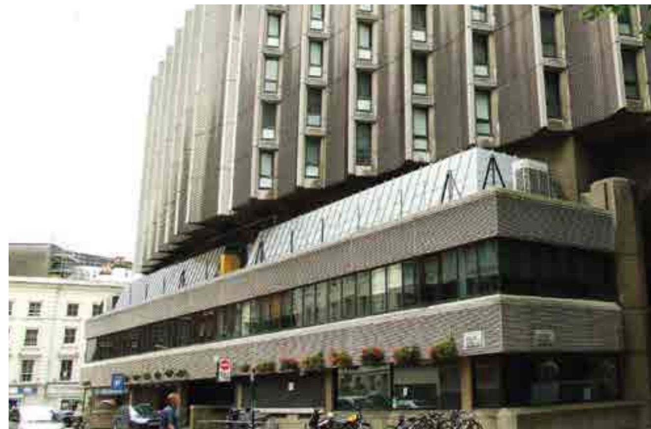
regularne podziały szerokich witryn – elementy charakterystyczne dla modernizmu – uspokajają i harmonizują witrynę
