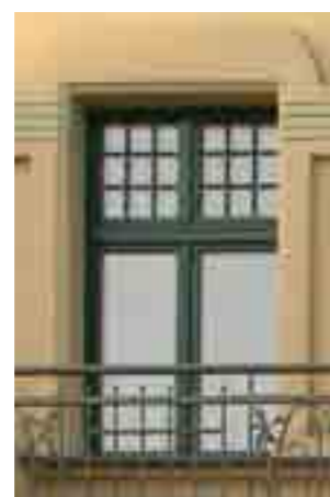
stolarka okienna kamienicy pod nr. 41
