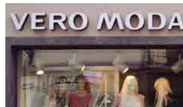
kolor liter przestrzennych harmonizuje z kolorystyką elewacji
