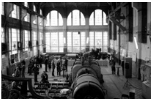
Secesyjna elektrownia w zakładach Scheiblera.
