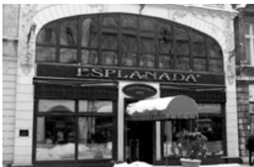
Budynek przy ulicy Piotrkowskiej 100a.
