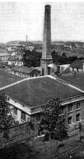
Fabryka Geyera po zachodniej stronie Piotrkowskiej – część pierwszego łódzkiego imperium przemysłowego z I połowy XIX w.
