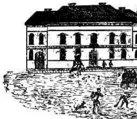
W 1856 r. na Rynku Nowego Miasta wzniesiono jednopiętrowy budynek na potrzeby szkoły niemiecko-ruskiej.
