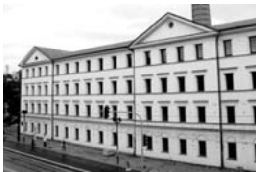
Geyer zbudował Białą Fabrykę i inne obiekty na dawnych gruntach Augusta Potempy.
